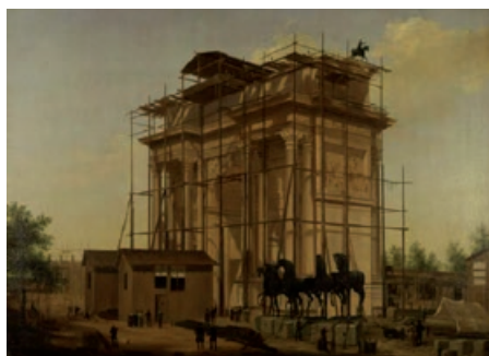
Pompeo Calvi (Milano 1806 – Milano 1884) Arco della Pace in costruzione Olio su tela, 1837
